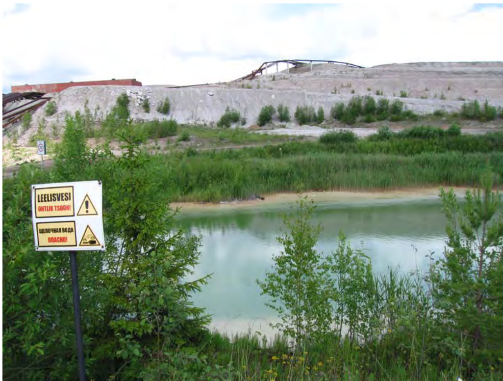
Foto 3.5. Eesti Elektriijaama tuhamägi ja selle piirdekraav. Photo 3.5. Ash hill and surface drain of Estonian Thermal Power Station.
