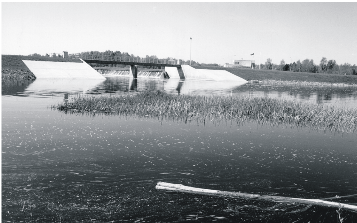
Foto 27. Vaskjala veehoidla pais regulaatoriga Pirita jõel. T. Mardimi foto. Photo 27. Regulated weir of Vaskjala artificial lake on Pirita River.
