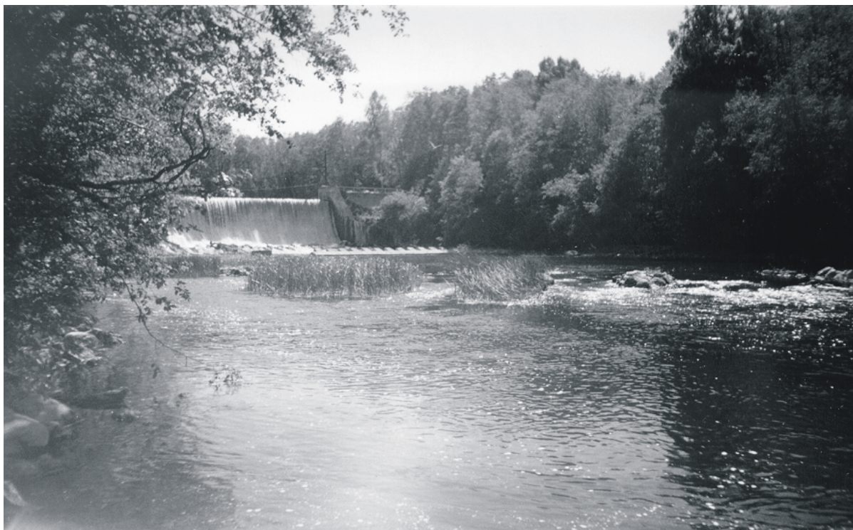
Foto 28. Linnamäe hüdroelektrijaam Jägala jõel. T. Mardimi foto. Photo 28. Linnamäe Hydroelectric PowerStation on Jägala river.
