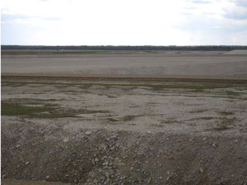
Foto 7. Balti Soojuselektrijaama tuhaplatoo. Photo 7. Ash plateau of the Baltic Power Plant.
