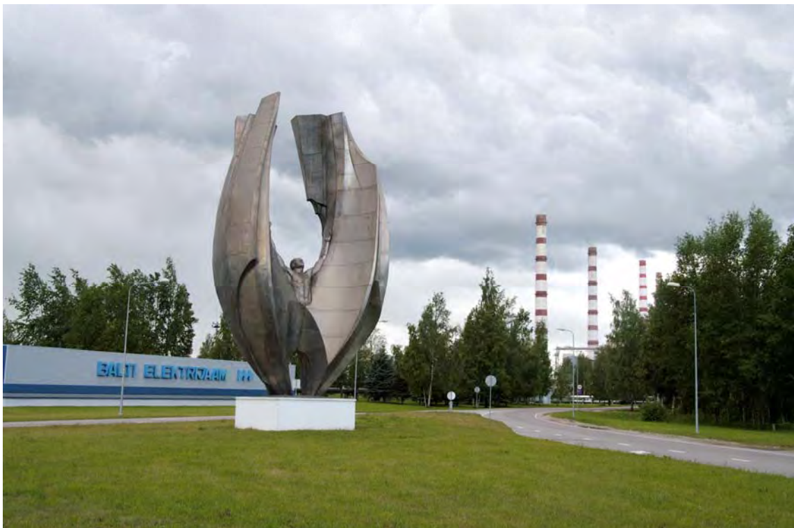
Foto 6. Balti Soojuselektrijaam. Photo 6. Baltic Power Plant.
