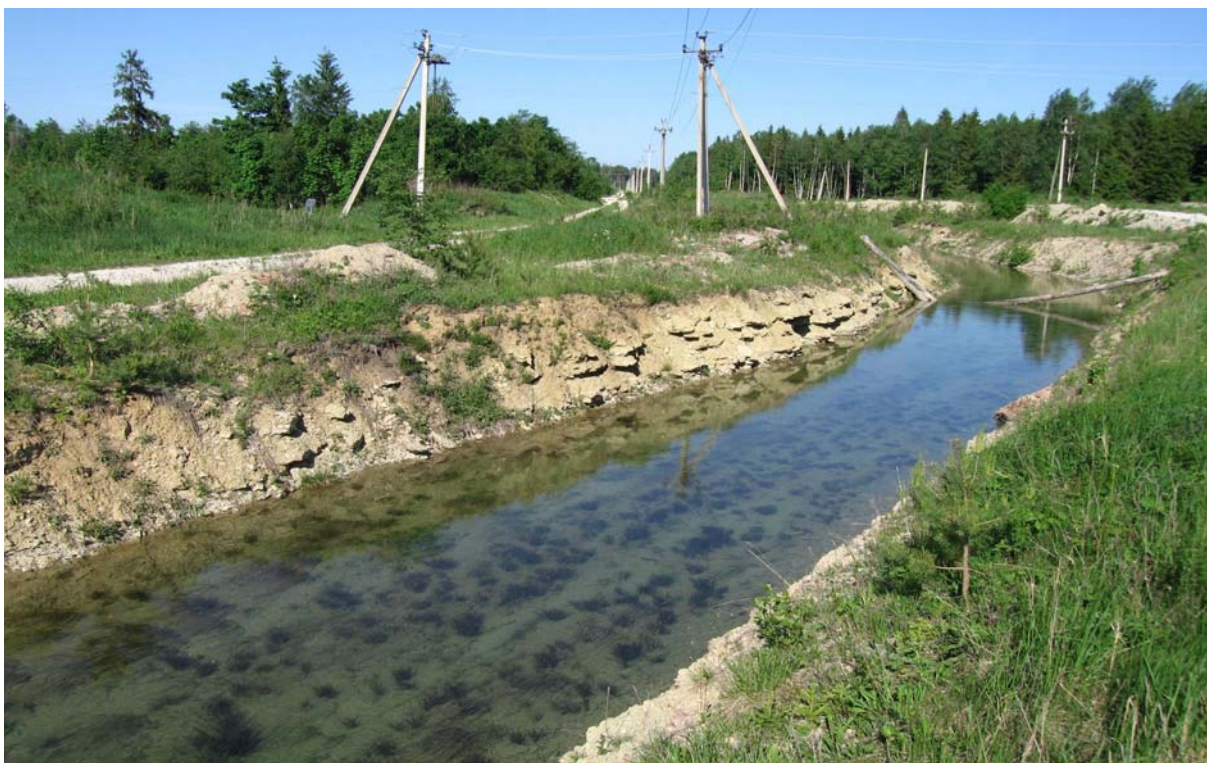
Foto 69. Aidu karjäär. Raudjõe äravoolukraav. Photo 69. Aidu quarry and flow-ditch of Raudjõe.
