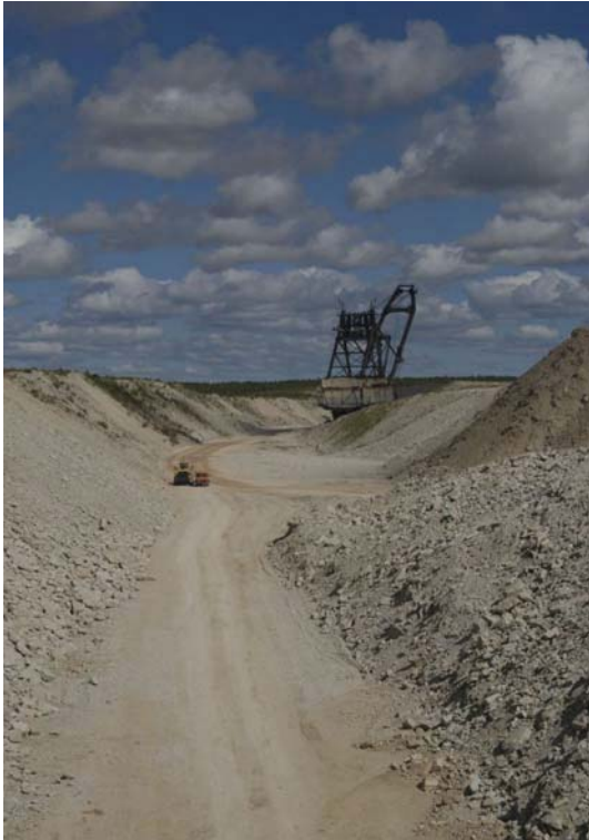
Foto 77. Vaade Aidu karjääri väljaveostrekile. Tagaplaanil Esku.
