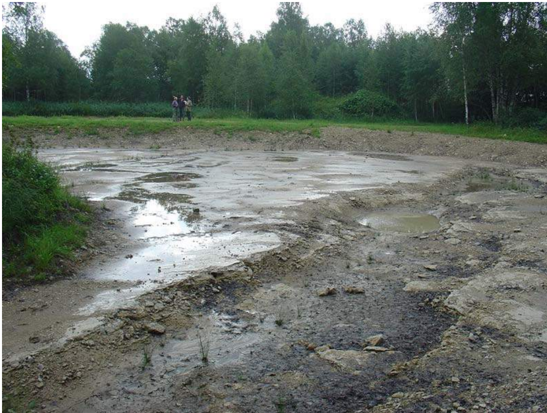
Joonis 2.5. Kulutatud lubjakiviplaad Adila tiigi põhjas.
