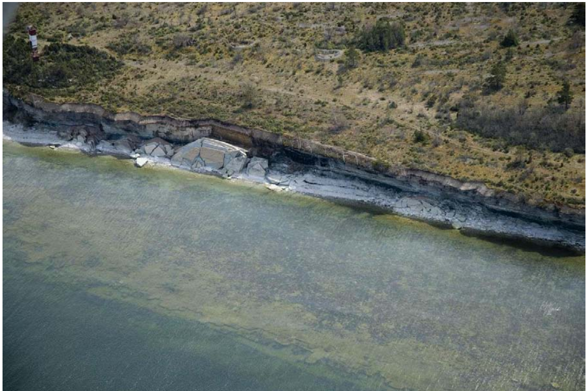
Foto 11. Õhuvaade Väike-Pakri pangale Photo 11. Aerial view to the Väike-Pakri Cliff
